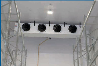
Cmara de Congelados – Evaporador com Streamer
