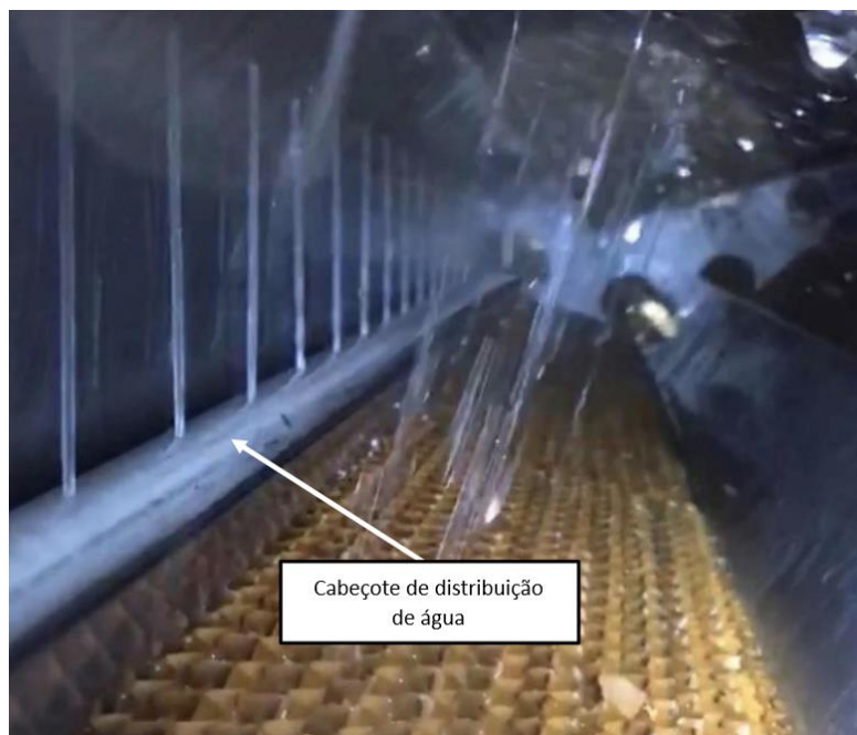
Figura 13 - Imagem do Cabeçote de distribuição de água em funcionamento.
