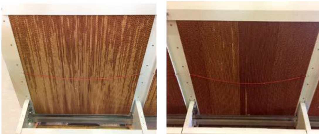
Figura 4. El agua se distribuye desde la parte superior de los paneles, que pasan de secos a saturados.
